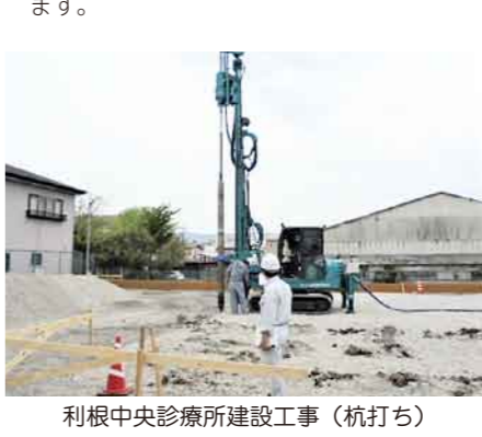
利根中央診療所建設工事(杭打ち)
