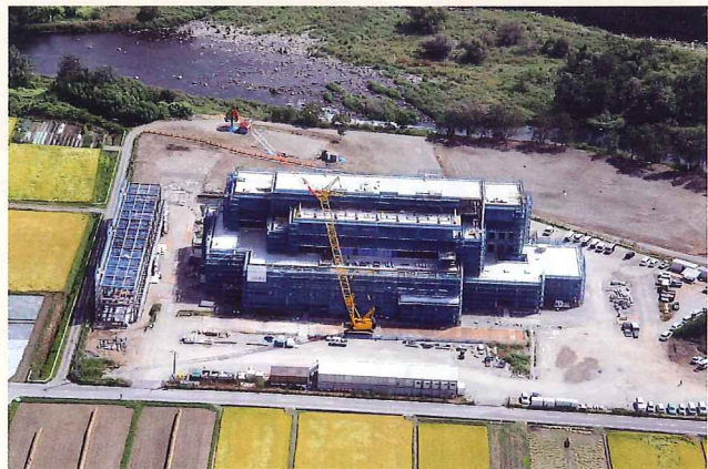
建設中の新病院
